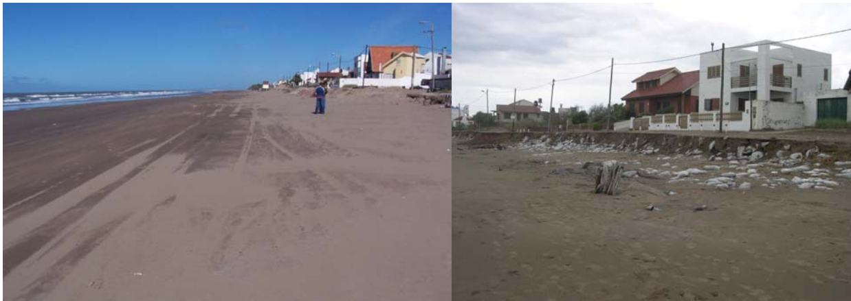
Figura 18. Fotografías del extremo norte de la urbanización en Las Toninas (perfil en Fig. 17), donde se observa el escaso desarrollo de la playa y la exposición de las construcciones (calles y viviendas) a la acción destructiva del mar.
