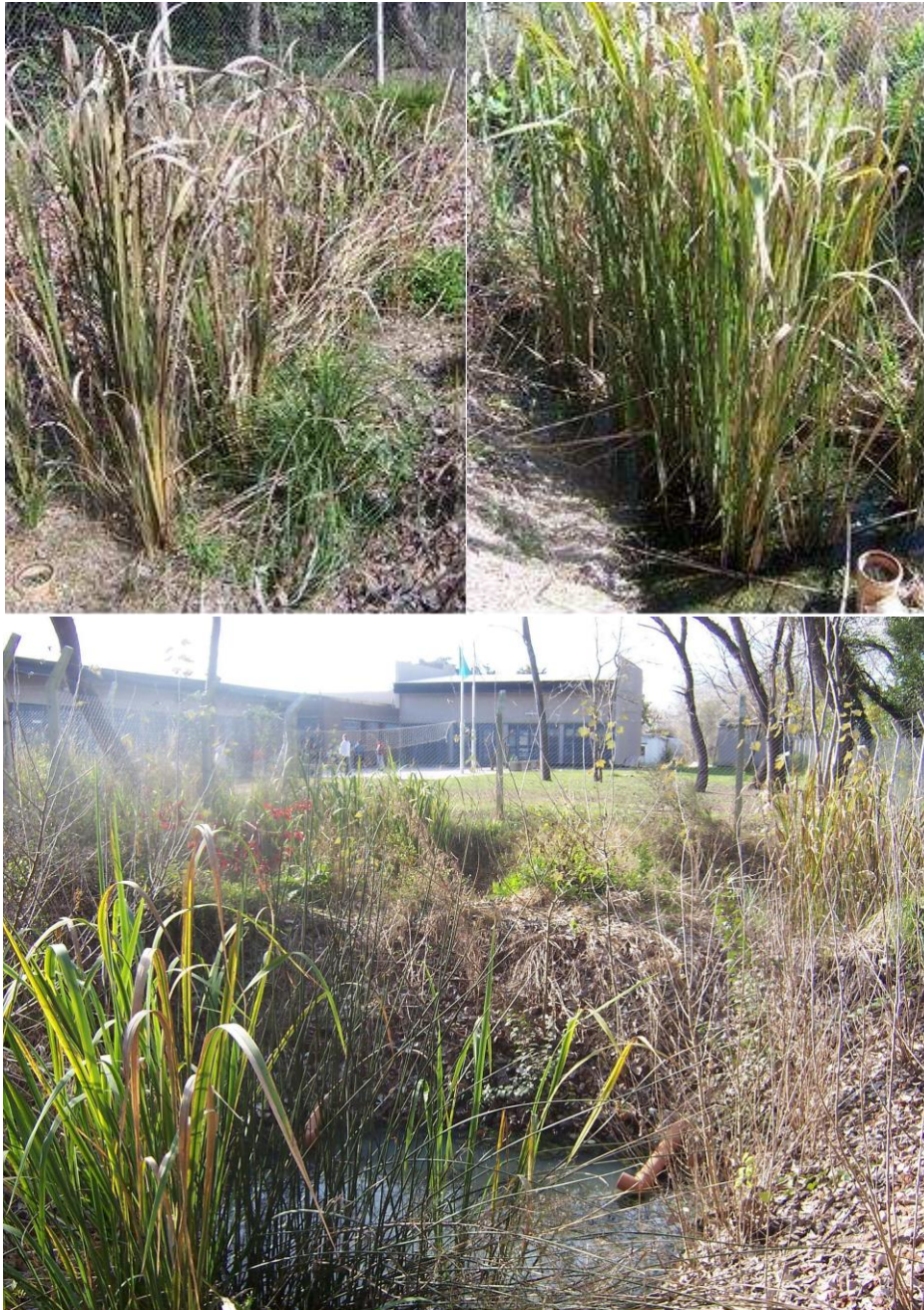
Figura 4.2. Fotografías de los humedales verticales ascendentes superficial (derecha) y sub-superficial (izquierda) y de la laguna de pulido (abajo)
