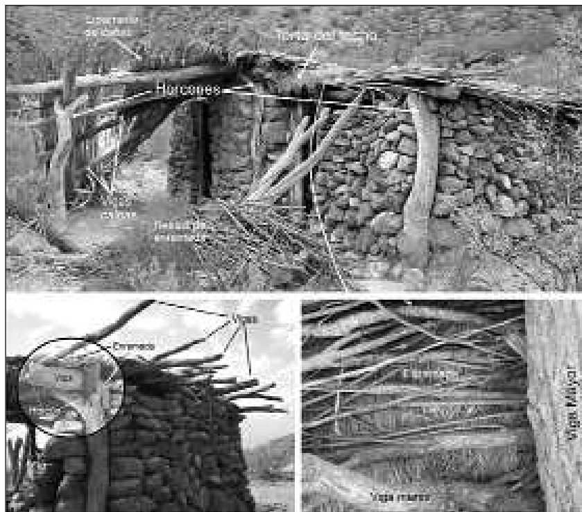
Figura 2 – Construcciones tradicionales y estructuras de sostén del techo en La Ciénaga
